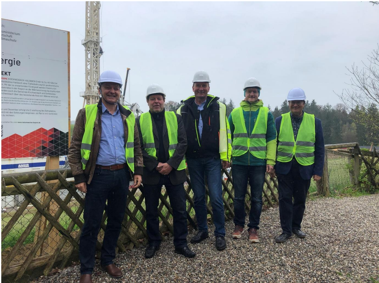
Besichtigung der Geothermie Baustelle Kirchweidach im Jahr 2023
